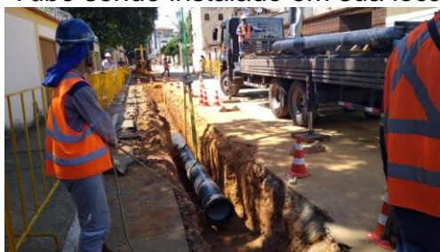
Figura 122 – Tubo sendo instalado em sua localização final.
